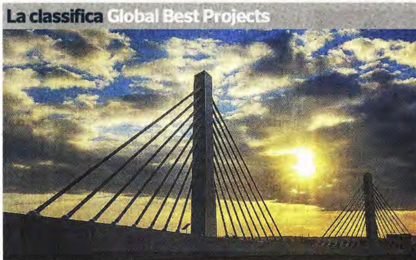
Lo Skytrain Bridge, parte della Sydney Metro Northwest realizzata in Australia da Salini Impregilo
