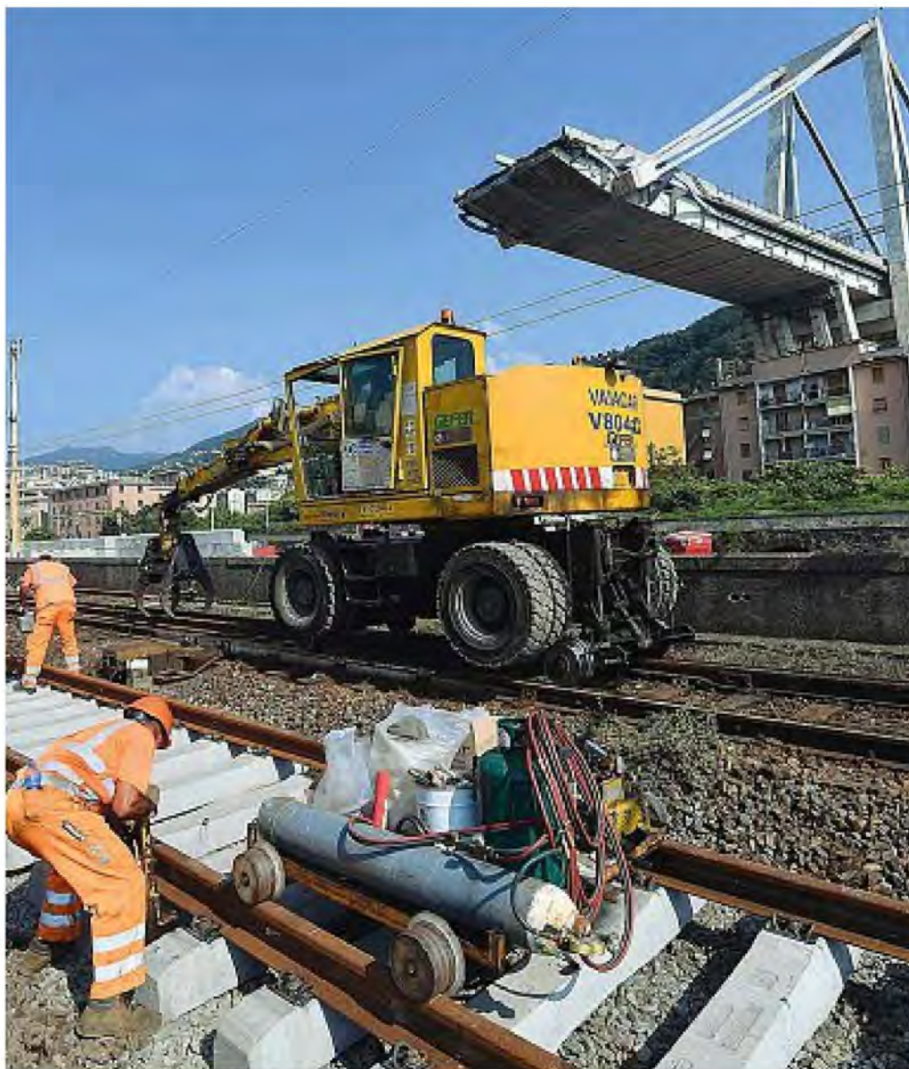
Cantiere Operai al lavoro sui binari per ripristinare la ferrovia danneggiata dal crollo del ponte Morandi (Ansa)
