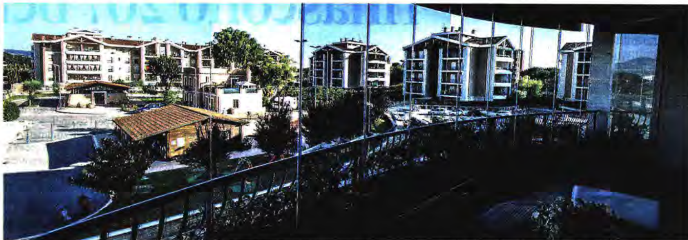
Terrazze. Anche le strutture sui balconi possono usufruire del bonus 50 per cento. Nella foto una realizzazione di Vetrate Panoramiche Italiane
