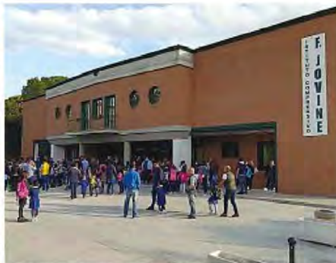
Sotto esame Verifiche in alcuni edifici dell'Istituto comprensivo Jovine
