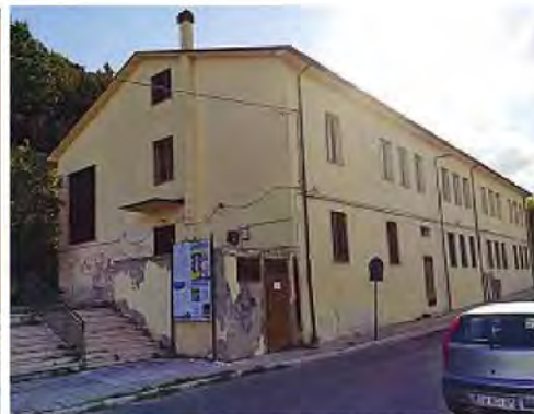
A rischio Tra gli edifici non sicuri anche la scuola di via Sant'Antonio Abate
