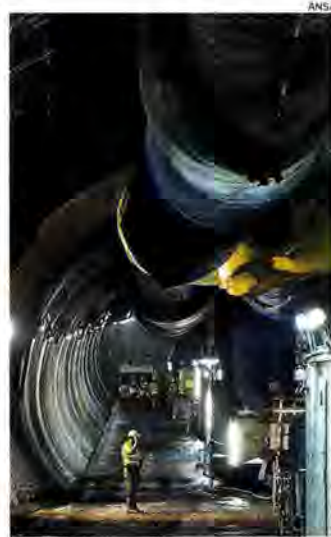
Tav. Operai a lavoro nel cantiere della Torino-Lione
