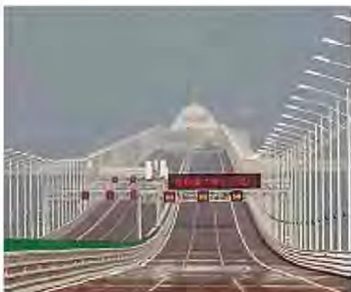
Isola artificiale Il ponte è lungo 55 km, aprirà in ottobre
