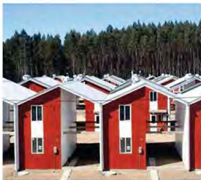
A metà. L'edilizia post-tsunami nel sud del Cile. I moduli abitativi vengono consegnati in tempi brevi e personalizzati in seguito
