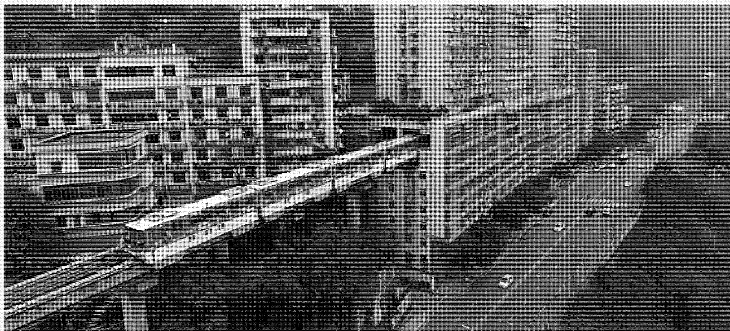
Chongqing La linea numero 2 della metropolitana della megalopoli cinese passa in mezzo a una serie di condomini alti 19 piani. La stazione Liziba occupa tre piani
