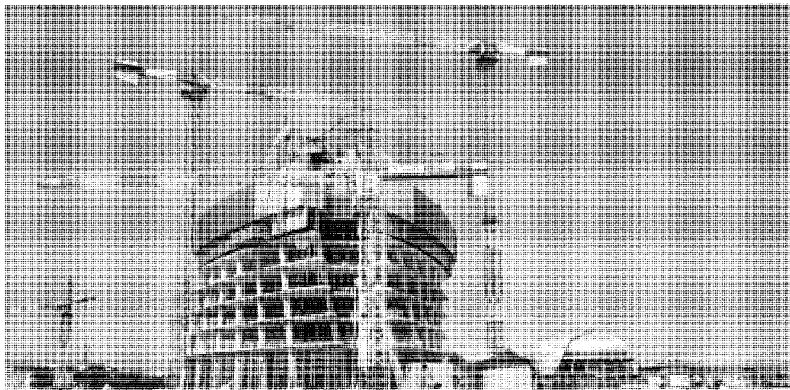
Milano. I lavori di costruzione di uno dei grattacieli di CityLife: la torre progettata dall'archista Zaha Hadid sarà ultimata nel 2016
