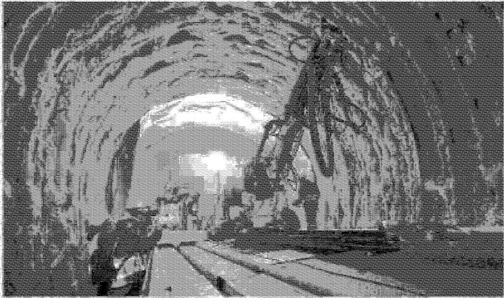
I lavori per lo scavo del tunnel esplorativo di Chiomonte
